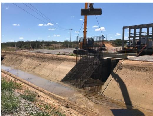
Manutenção corretiva na grade de proteção do poço de sucção
