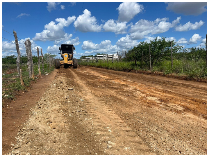
Intervenção em estrada no Núcleo 9
