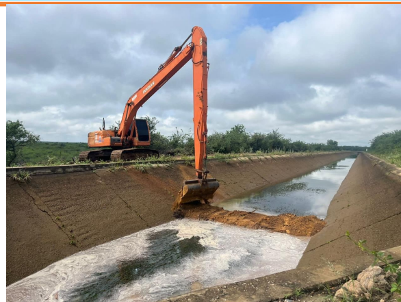
Desassoreamento do Canal — 1ª Parada
