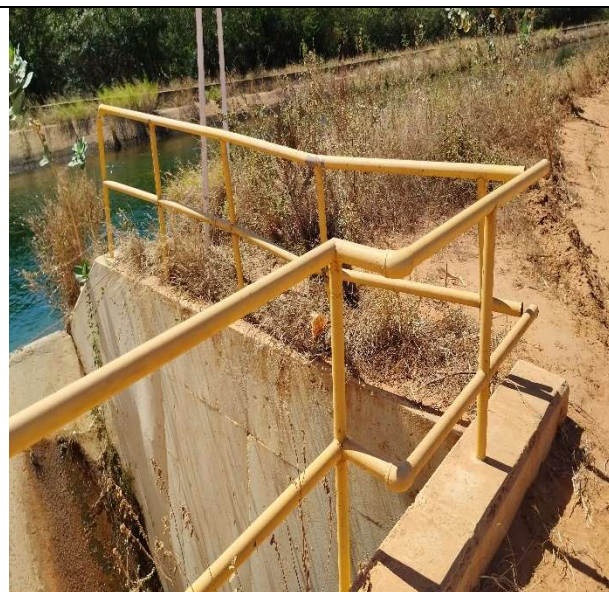
FOTO 6: Pintura Guarda Corpo Metálico
