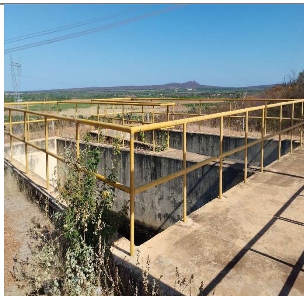
FOTO 2: Pintura Guarda Corpo Metálico
