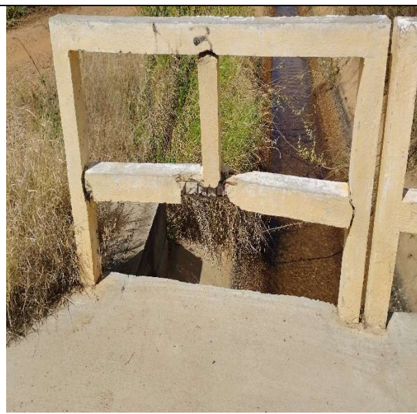
FOTO 12: Recuperação de Guarda Corpo em concreto
