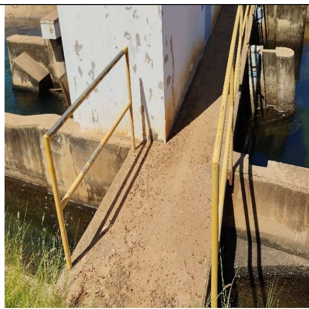
FOTO 16: Pintura de Guarda Corpo em Metálico
