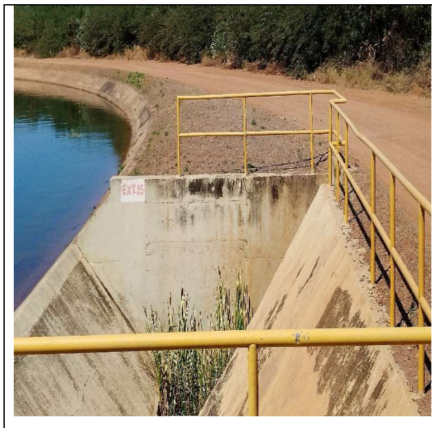
FOTO 5: Pintura e identificação de extravasor
